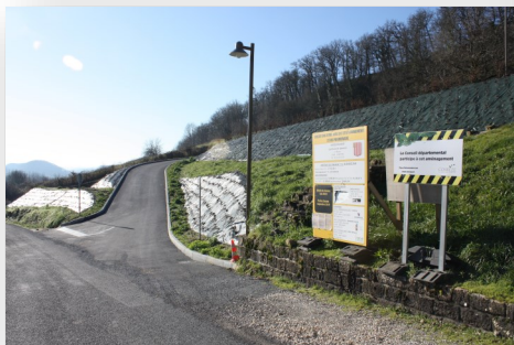
Accès au parking
